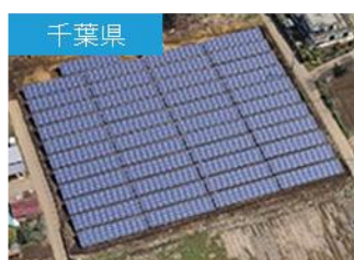
S-03 LS千葉若葉区発電所
