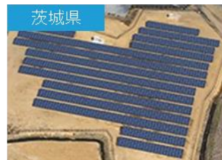
S-02 LS筑西発電所
