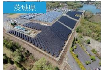
S-33 LS桜川2・3発電所
